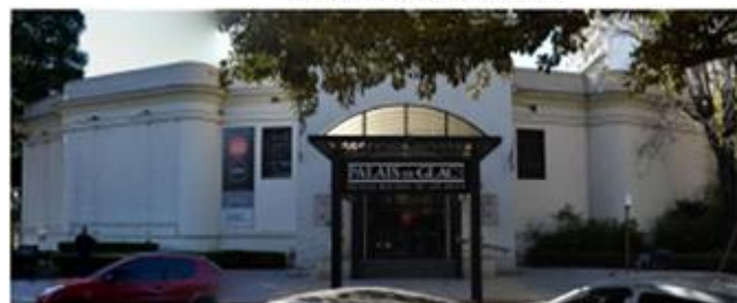
Fachada Posadas – Año 2015
