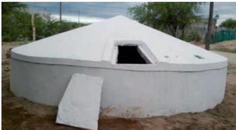
**Figura 7** – Cisterna de placas de mortero de cemento
